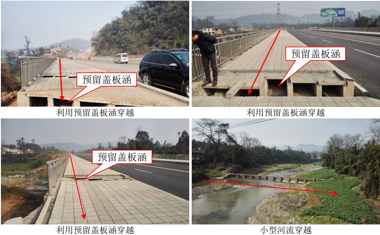
图 1-5 管道河流穿越实景
