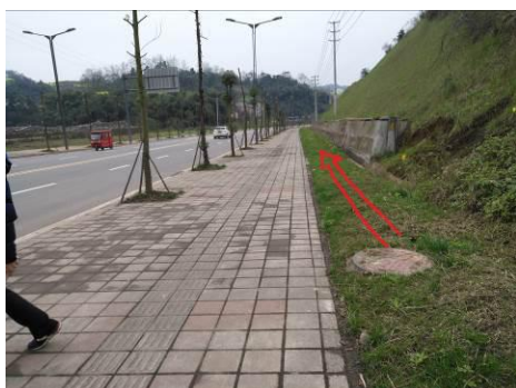
永兴大道北段管道走向
